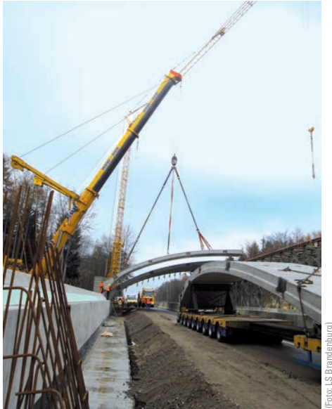
Bild 4 Transport und Montage der Fertigteile Transport and installation of the prefabricated segments
