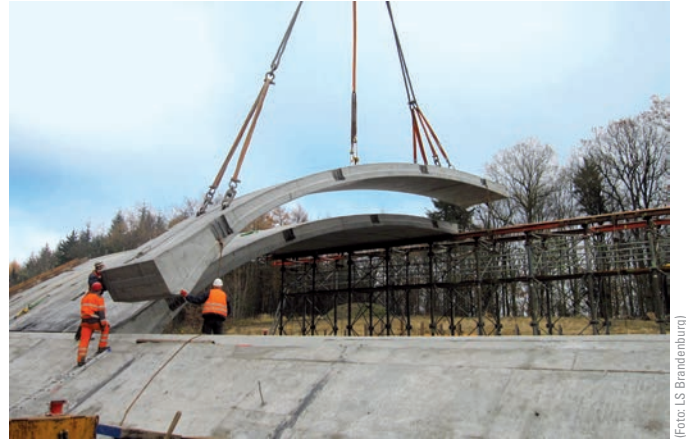
Bild 5 Halbseitige Verlegung der Bogensegmente Half-sided installation of the arch-segments
